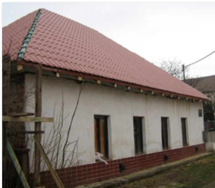
Rekonštrukcia domu pre sociálne slabé rodiny
